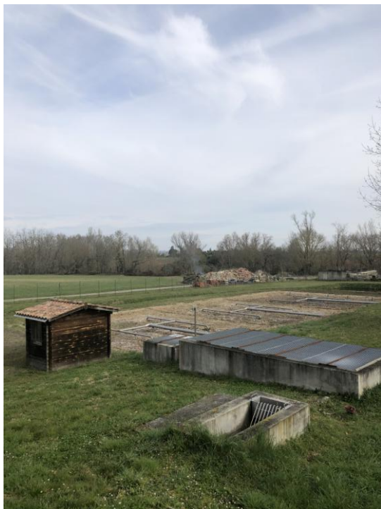
Fotografía 3. Vista del humedal artificial a fines del invierno, las cañas han sido cortadas y retiradas
